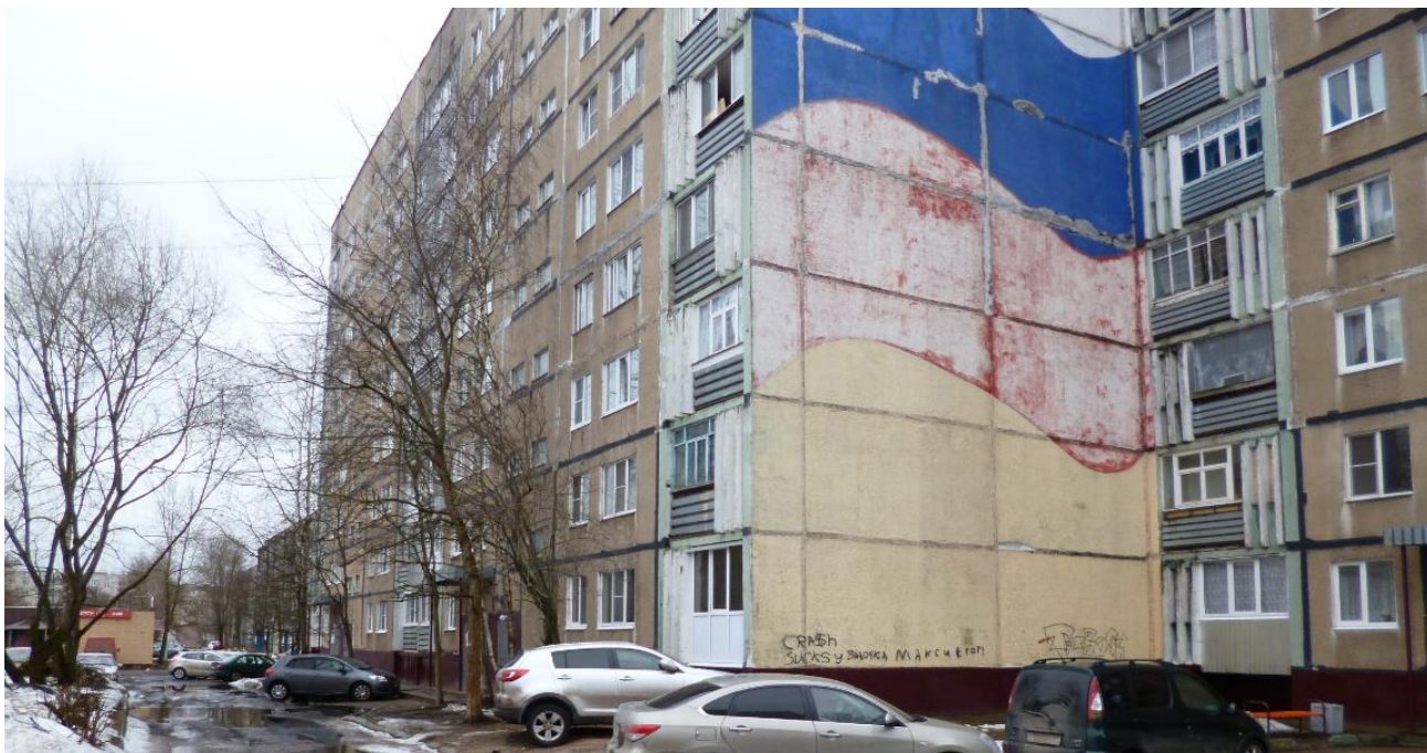
Фото Ф-2.1.1. Общий вид здания в осях «26-14/Е'-А'»
