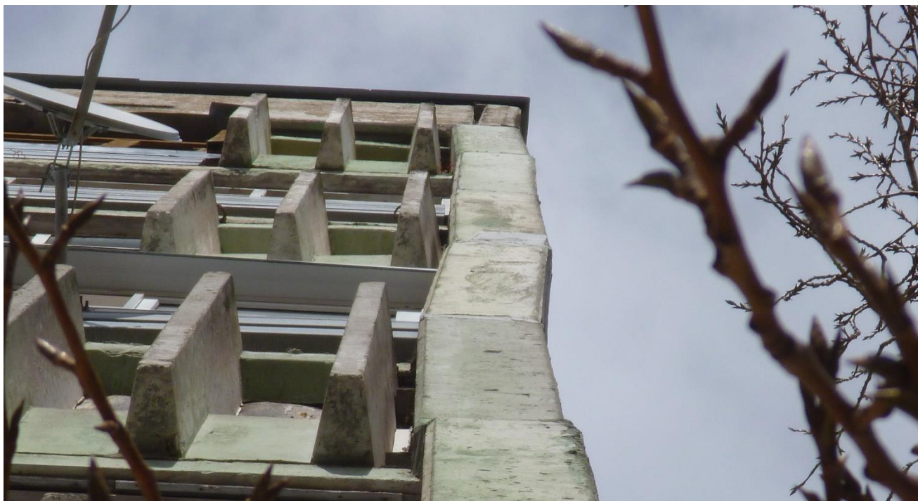
Фото Ф3.2.3.5. Отклонение стеновых панелей по вертикали относительно друг друга.
