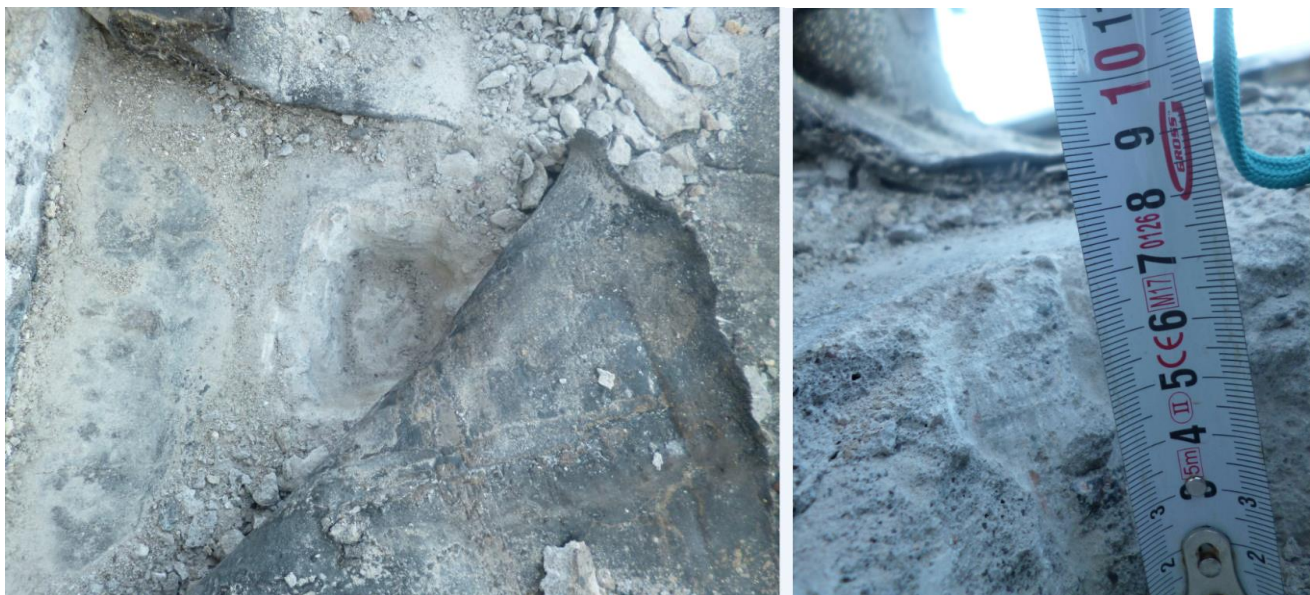
Фото Ф-3.5.1.2. Вскрытие кровельного «пирога»
