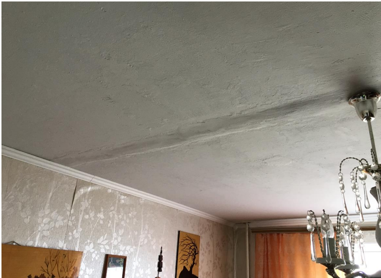
Фото Ф-5.33. Состояние внутренних помещений обследуемого дома
