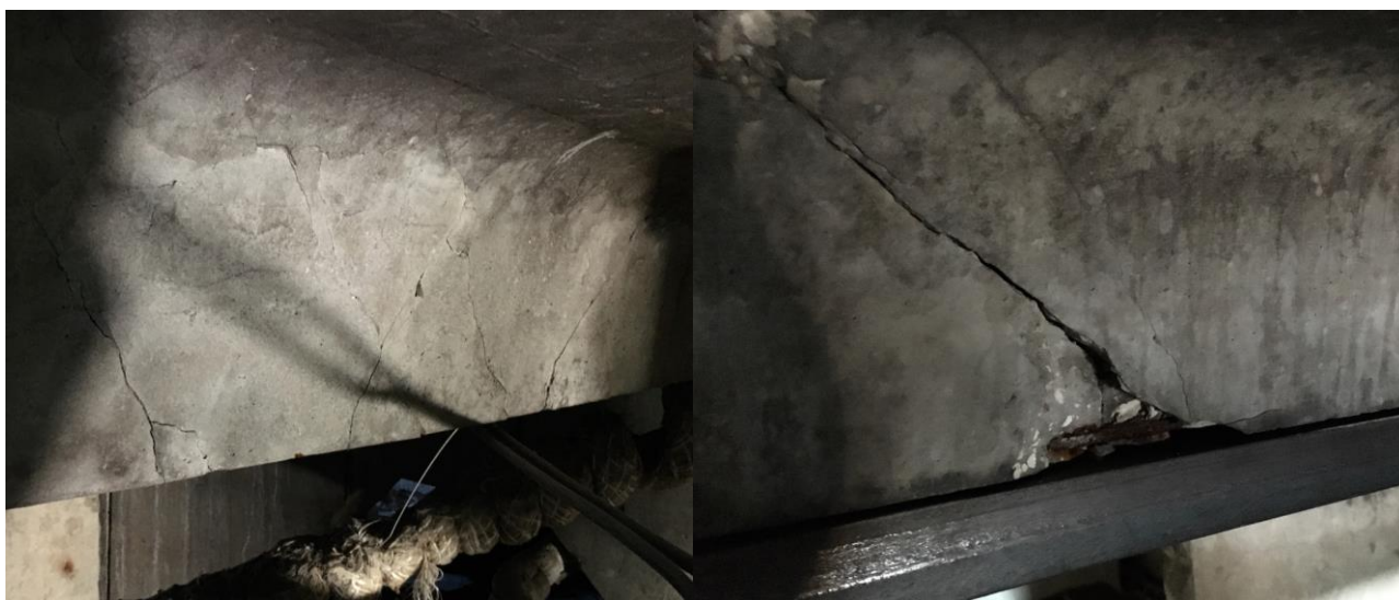
Фото Ф-3.5.7. Плита на участке в осях 12-13/А'-В'
