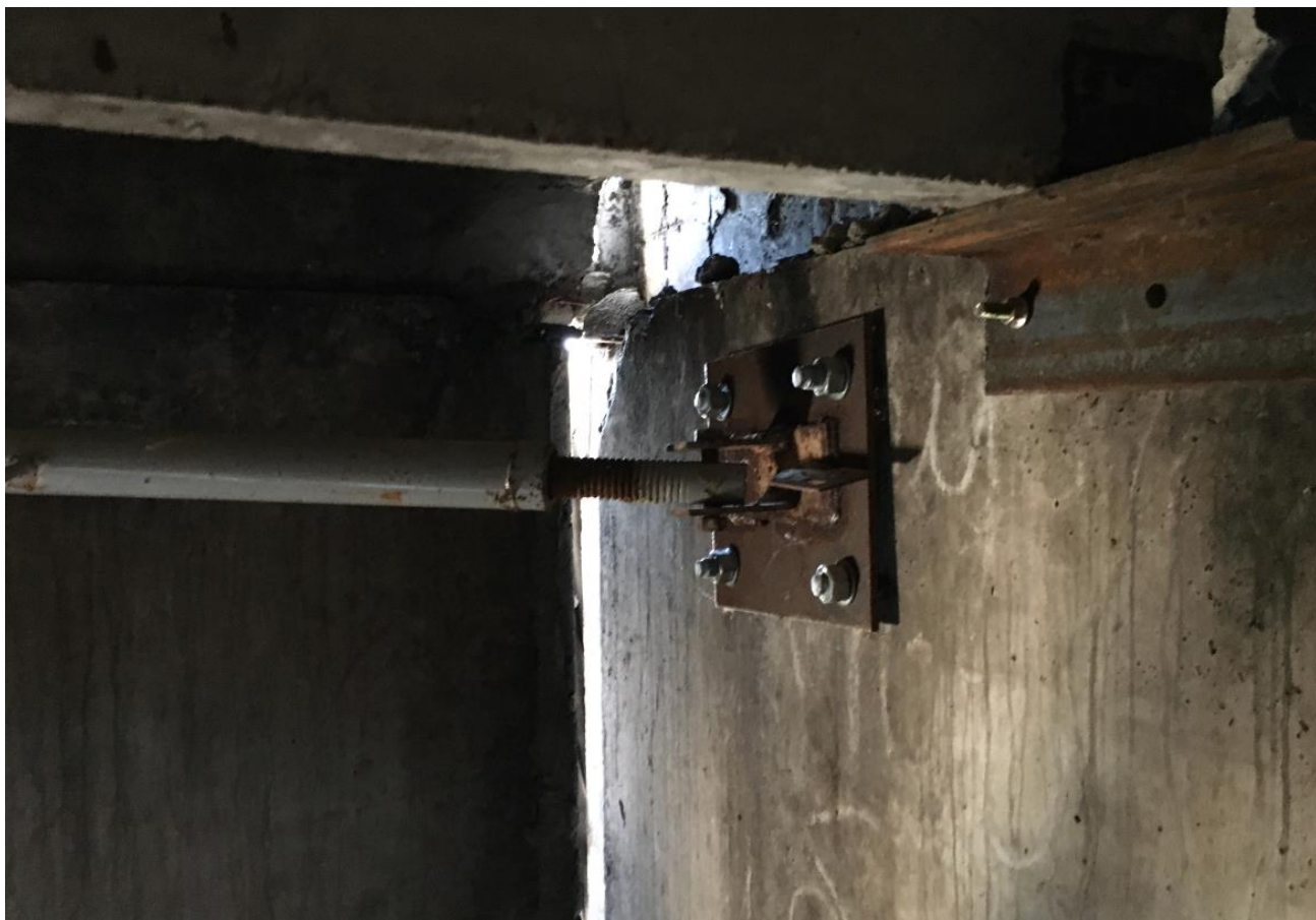
Фото Ф-5.14. Закрепление парапетной панели в осях 1/А-В
