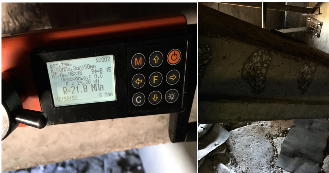
Фото Ф-3.5.11. Определение прочности бетона плиты покрытия ПР-36-12-1
