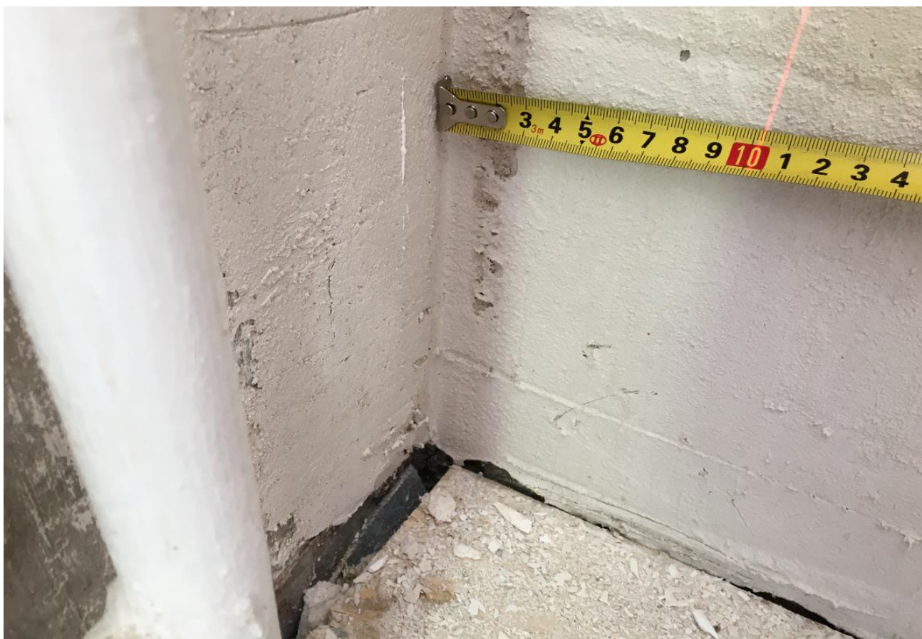
Фото Ф-5.34. Измерение отклонений наружной стеновой панели с помощью рулетки и построителя лазерных плоскостей ADA Cube Basic Edition A00341.
