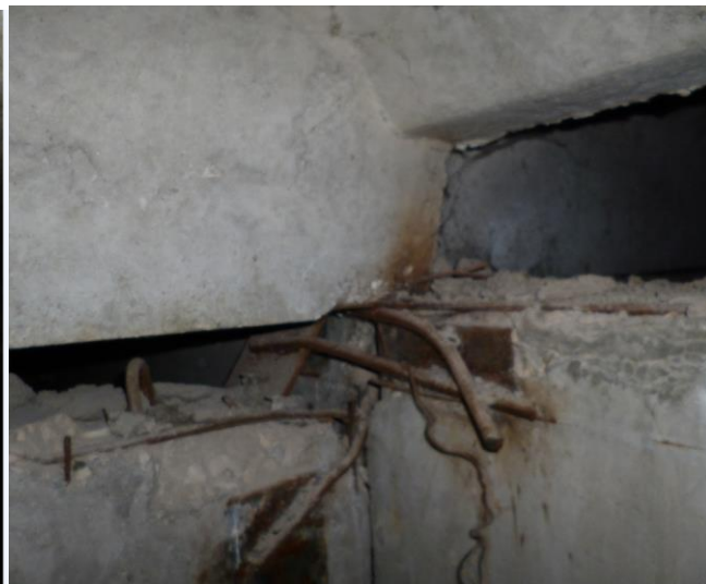
Фото Ф-3.5.13. Типичное состояние узловых соединений на обследуемой крыше
