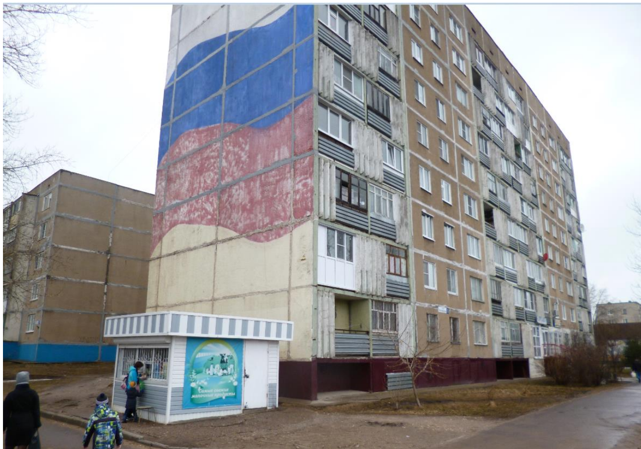
Фото Ф-2.1.6. Общий вид здания в осях «Е-А/1-13»
