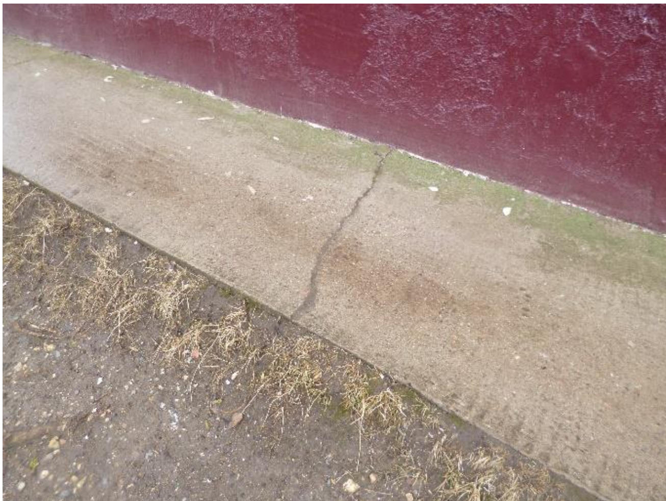
Фото Ф3.2.1.2. Состояние отмостки.
