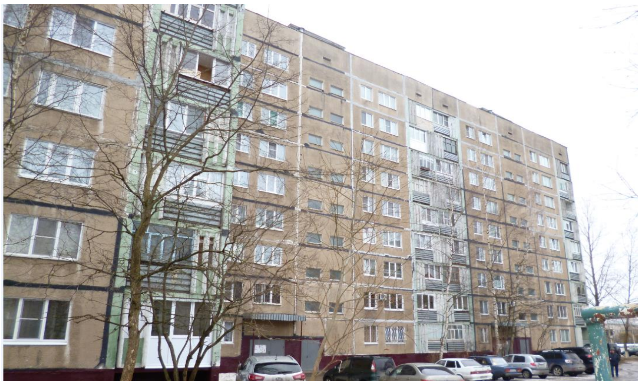
Фото Ф-2.1.2. Общий вид здания в осях «13-1»
