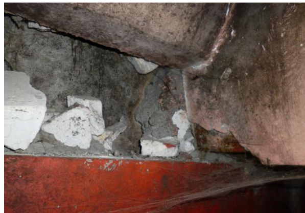
Фото Ф-3.5.10. Значительные грибковые образования на плитах покрытия в разных участках крыши
