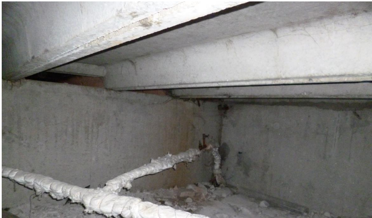
Фото Ф-3.5.1. Общий вид плит покрытия
