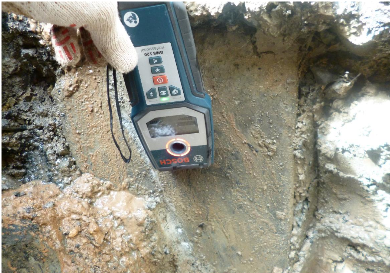
Фото Ф-5.31. Определение расположения рабочей арматуры в сваях
