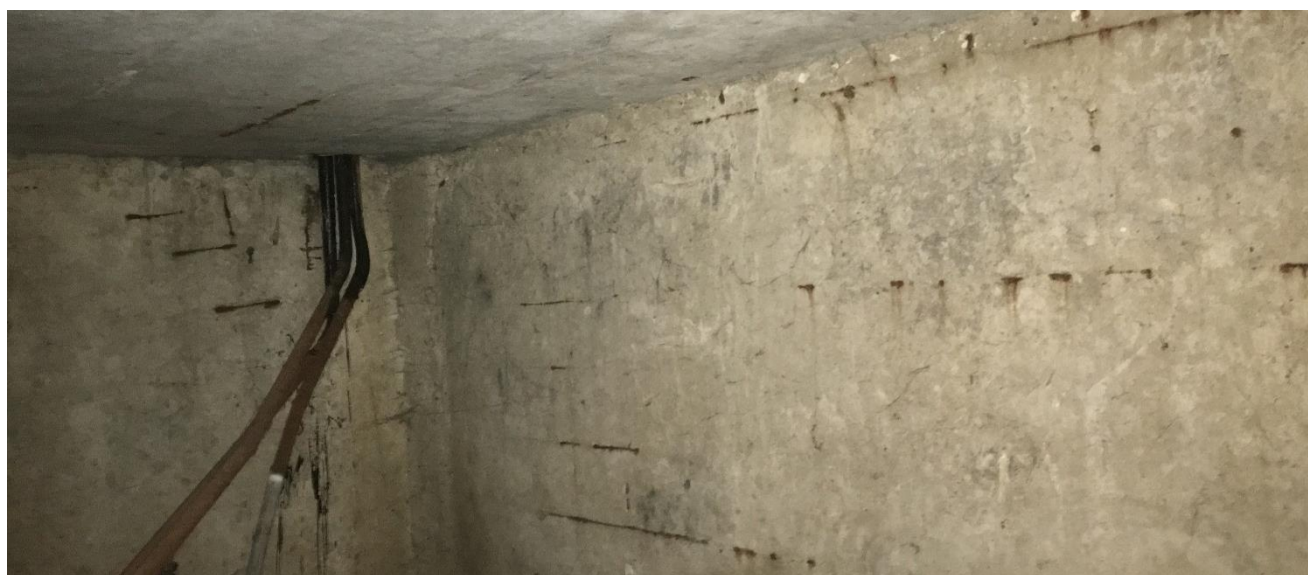
Фото Ф3.3.1. Внутренние стеновые панели подвальных помещений.
