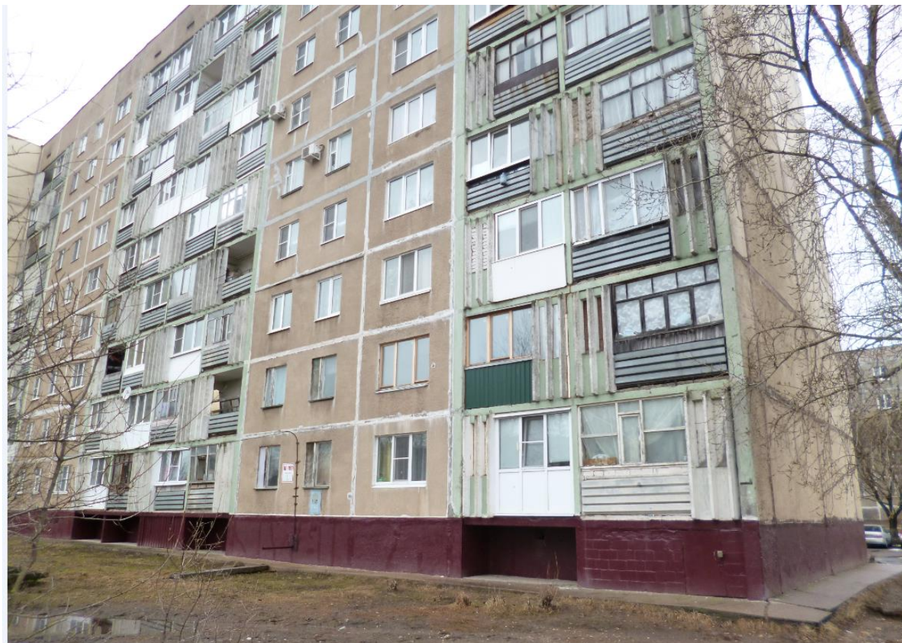
Фото Ф-2.1.5. Общий вид здания в осях «14-26»
