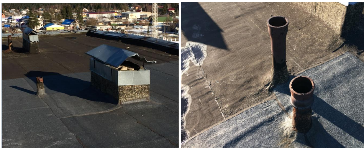
Фото Ф-3.5.1.5.Состояние канализационных выпусков, колпаков вентиляционных шахт
