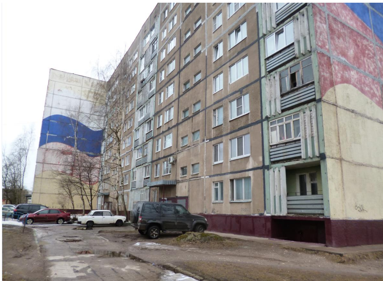
Фото Ф-2.1.4. Общий вид здания в осях «13-1/Е'-А»
