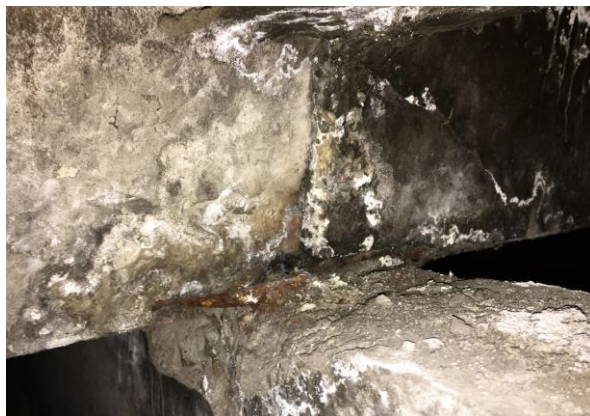
Фото Ф-3.5.10. Значительные грибковые образования на плитах покрытия в разных участках крыши
